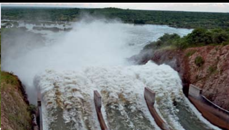
Bild: Überlaufrinne des Ithezi-Tezhi-Staudamms am Zufluss zum Feuchtgebiet der Kafue-Flats; Alfred Wüest, Eawag
